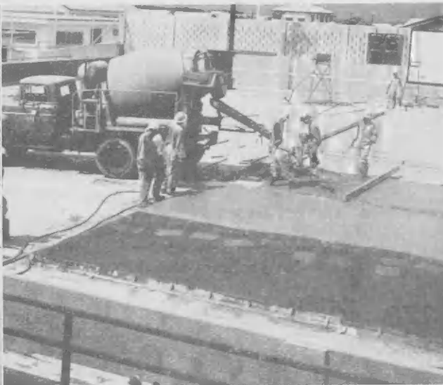
PA ASEGURA cu e formalete y latanan ta worde poni nivel, un waterpas ta sirbi como un referencia constante. Entre e formalete cu canaster di hero poni, concreto ta worde bashá, como 36 yarda cubico.
